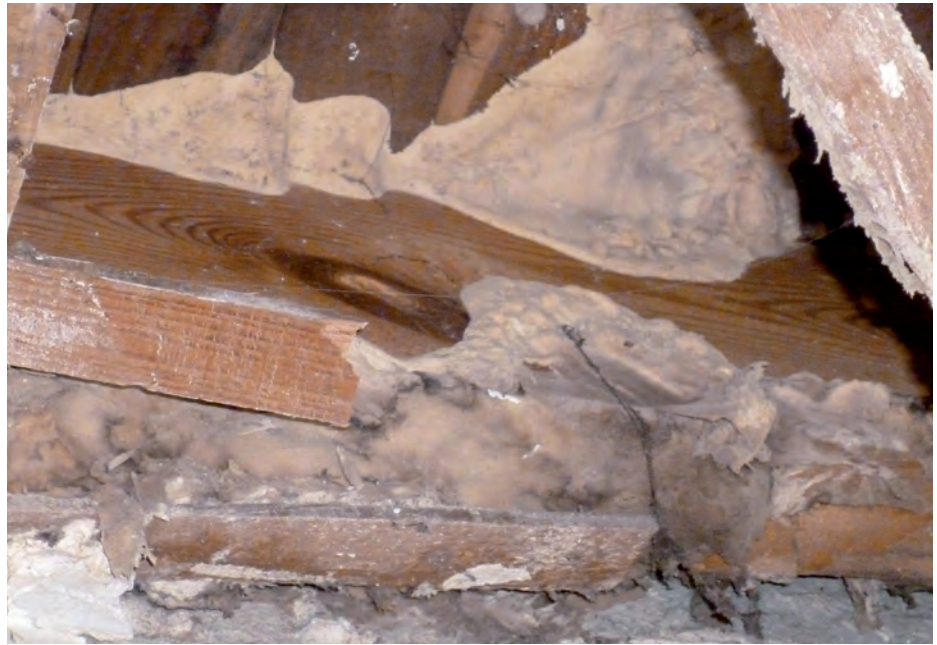
Méréule tremblante et ses dégâts.
